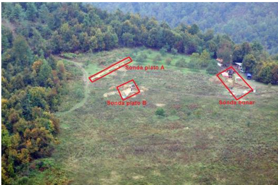
Sl.24 Plato Plješevice sa otkopanim istražnim sondama i bušaćom garniturom, na bušotini B2. (Ilustracija: Nadir Čukurija, novembar 2006)
