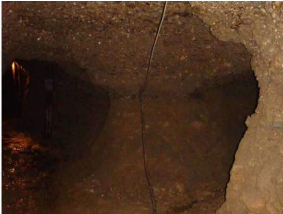
Fotografija 2: Konglomeratni materijal u podzemnom tunelskom kompleksu „Ravne“
